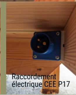
Raccordement électrique CEE P17
